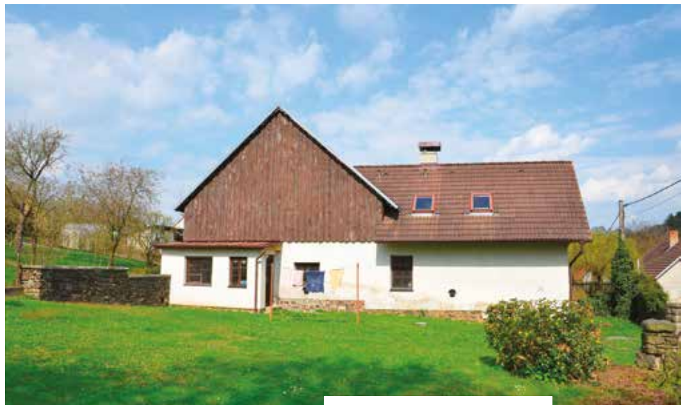
↑ Původní stav domu
