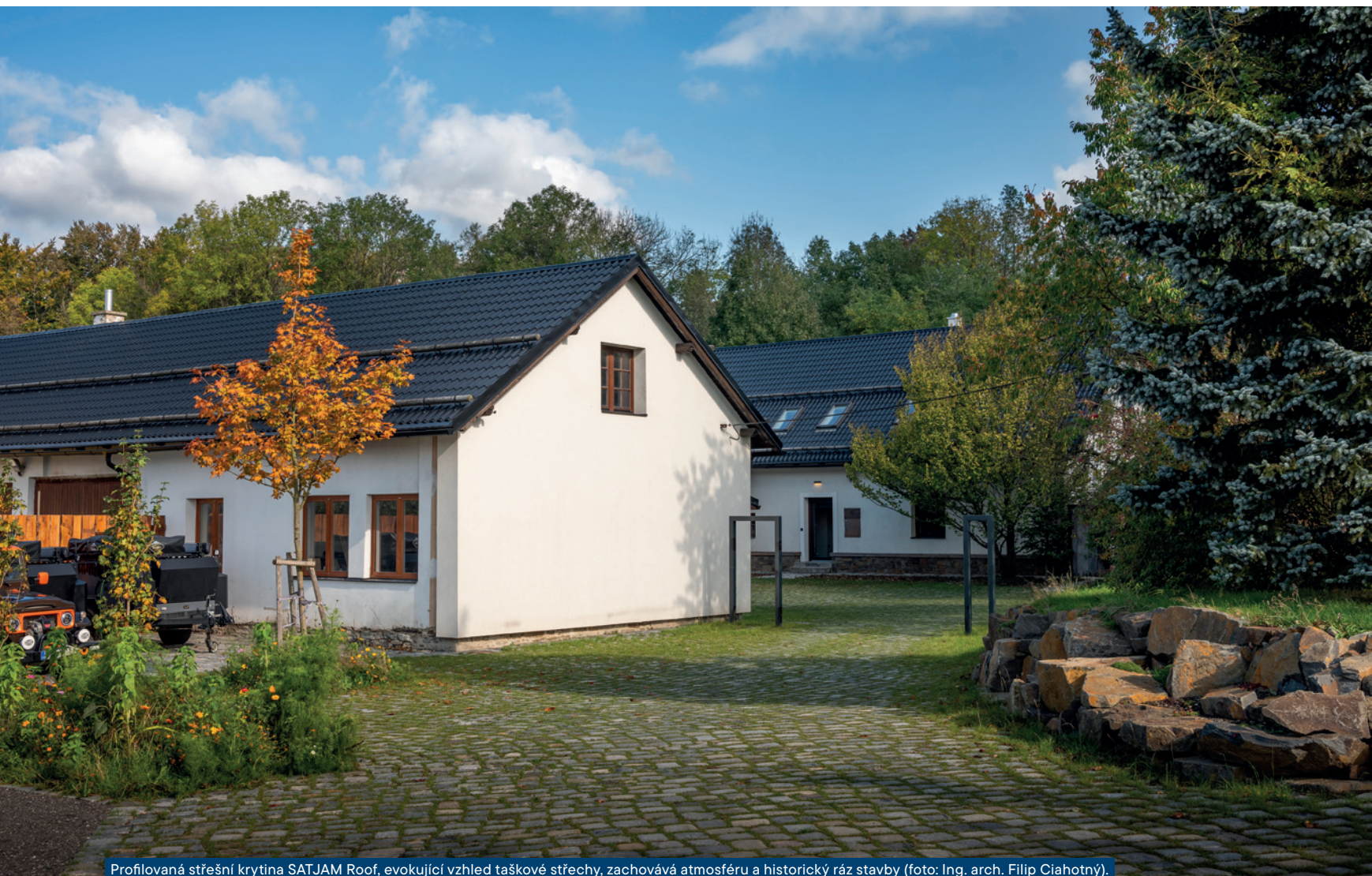
Profilovaná střešní krytina SATJAM Roof, evokující vzhled taškové střechy, zachovává atmosféru a historický ráz stavby (foto: Ing. arch. Filip Ciahotný).
