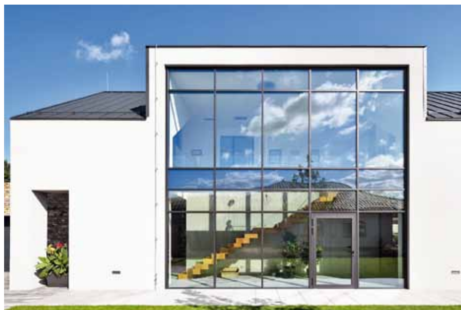
Prosklená stěna, jež dominuje západní fasádě, dům prosvětluje a v zimě přitápí sluncem.
