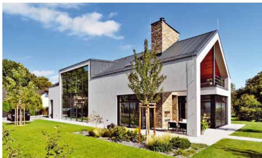
Krytá terasa s venkovním krbem je na jižní straně domu. Krb i komín má obklad z přírodního kamene. Vytápění domu zajišťuje tepelné čerpadlo vzduch-voda od Stiebel Eltron.
