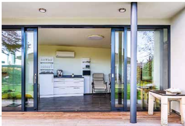
Zastřešení terasy tvoří přesah střechy, kterou podpírají kovové sloupky.
