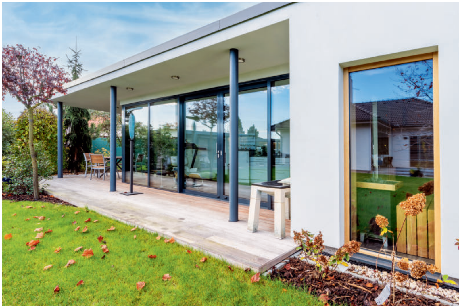
Prodloužená část střechy, kterou podpírají čtyři nosné ocelové sloupky, poskytuje rodině kryté venkovní posezení.
