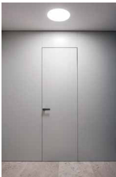
Interiérové dveře byly vesměs navrženy na míru se skrytými zárubněmi, aby splývaly se stěnami a obklady
